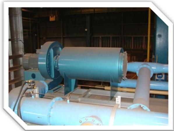
Fig. 4 Combustion air fan
